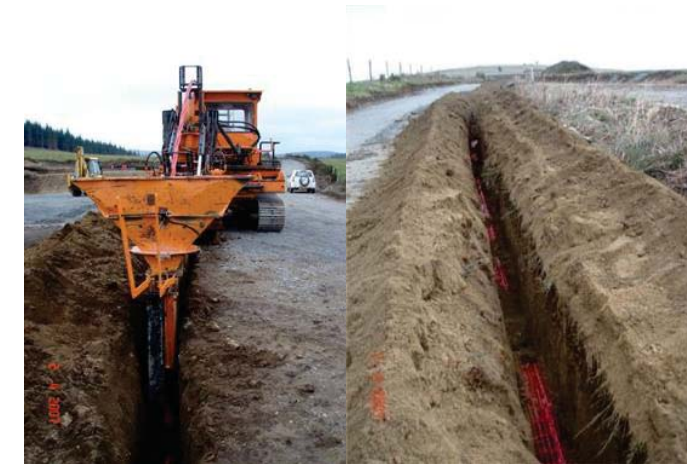
FIGURE 2 : REALISATION DE LA TRANCHEE ET POSE DES CABLES
