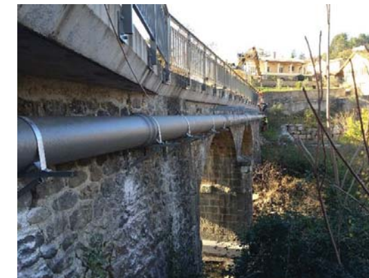
FIGURE 5 : EXEMPLE D'ENCORBELLEMENT (SOURCE : RAMPA-TP.COM)
